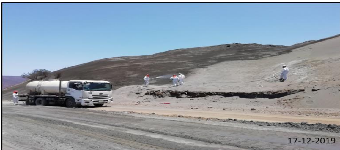
Durante aplicación de Aglosil 21 en Talud lado Sur. Coordenadas UTM (WGS84/Huso 19 J) Norte 6.656.653- Este 283.803
